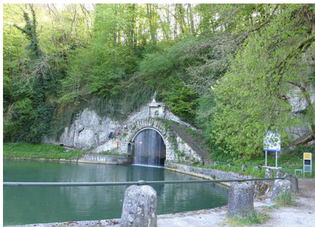
Percée de Thoraise (entrée amont du tunnel)
