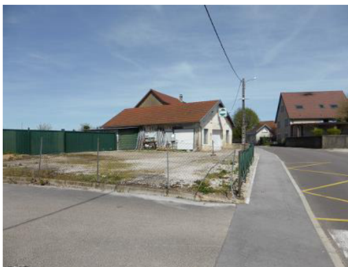
1 : Ce bâtiment et sa cour clôturée dénuée de toute plantation constituent une « verrue » dans le centre ancien de Thorse.
