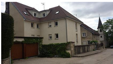
11 logements collectifs aménagés sur la Place Centrale
