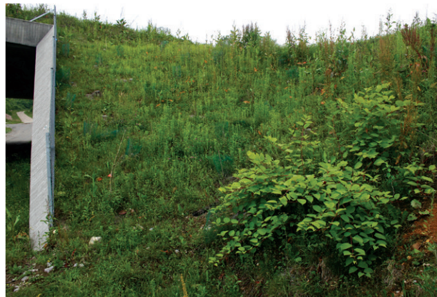
Installation de Reynoutria japonica Houtt. sur un talus routier récemment aménagé.
