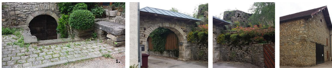
1. Descente de cave, seuil pavé et banc en pierre. 2. Mur de pierre et vestige de la muraille médiévale.
