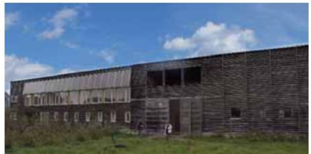
Utilisation des énergies renouvelables
