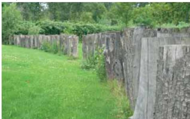
Des pieux de bois comme "clôture"
