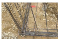
Nœud de chaînage - Continuité mécanique
