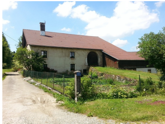
Chemin rural dit de la Cité
