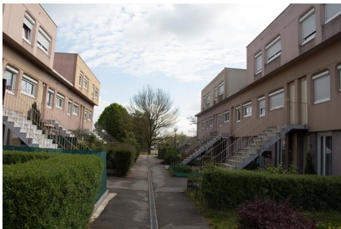
Habitat intermédiaire innovant lors de sa date de construction
