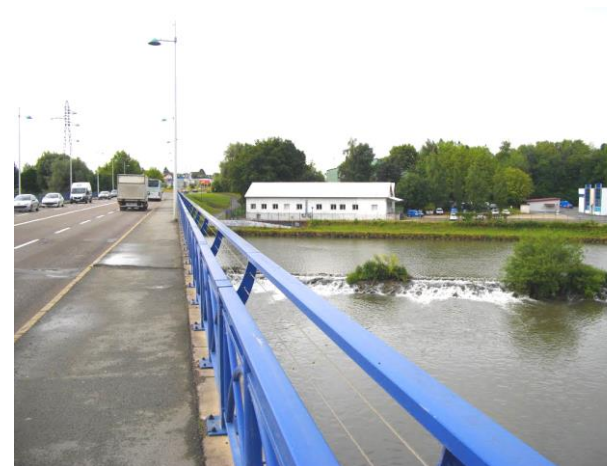
Déversoir sur l'Allan, côté Exincourt
