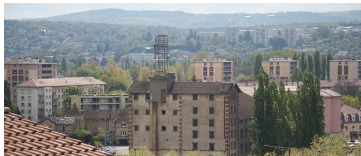
Photo 46 : Vue sur l'ancienne malterie
