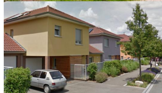
Belfort, rue de Barcelone
