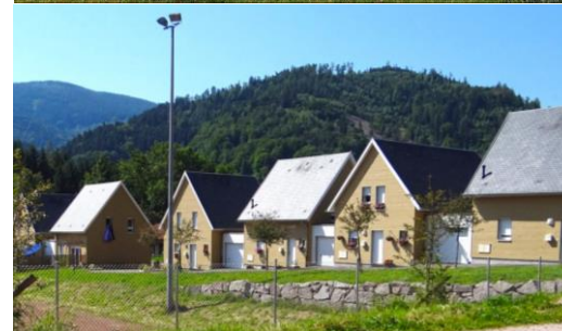
Une opération d'habitat individuel groupé sur une parcelle en « dent creuse » le long de la Liepvette à Sainte-Marie-aux-Mines
