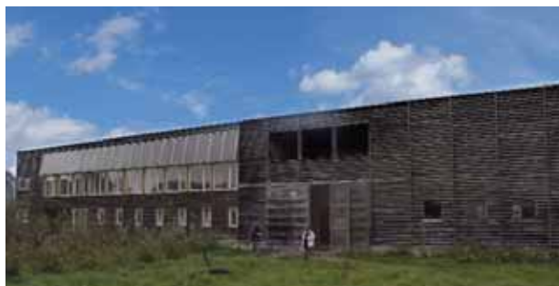
Utilisation des énergies renouvelables
