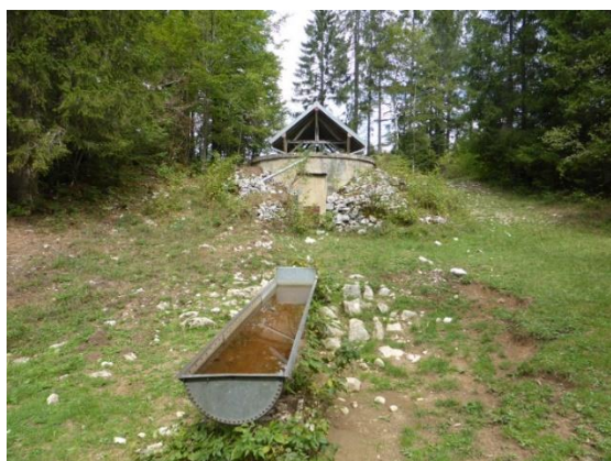
Citerne sur les communaux sud du Val
