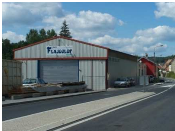
Entreprise Flajoulot - Grande Rue
