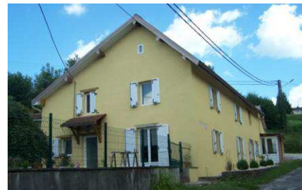
Toiture à 2 pans asymétriques
