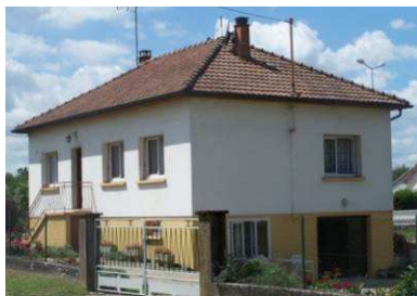
Toiture à 4 pans
