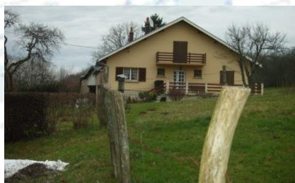
Construction intermédiaire au bout de l'impasse à la Suisse
