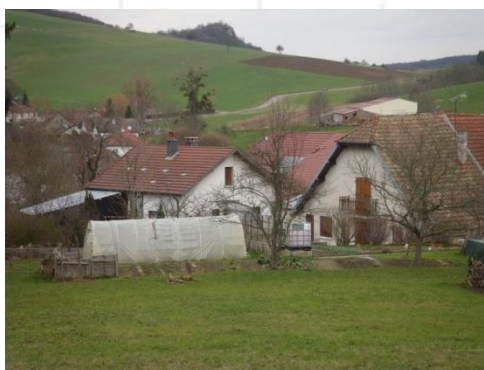
Constructions intermédiaires au Sud-Ouest du village
