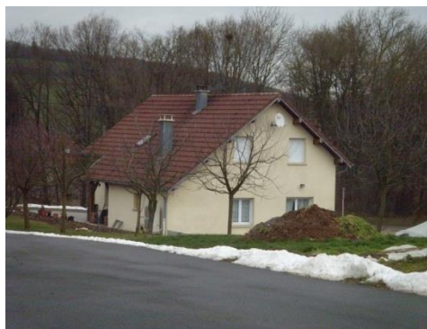
Construction neuve à l'Ouest du Bonnet Rond
