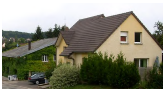
Construction récente à proximité d'une ancienne bâtisse
