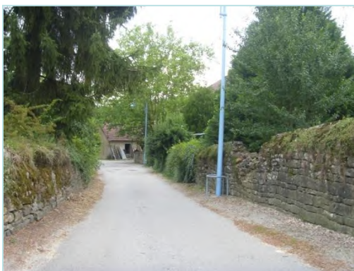
Mur de pierres au niveau du centre ancien
