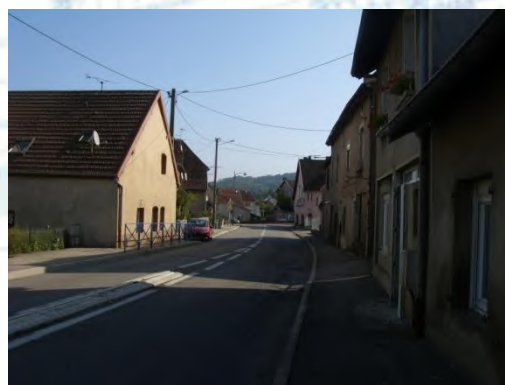
Constructions anciennes le long de la RD70
