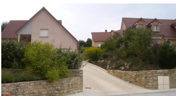
Constructions récentes surplombant la RD465
