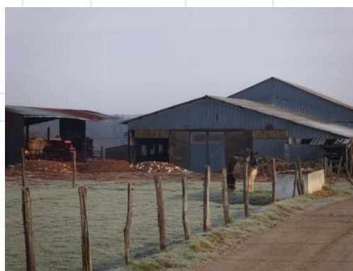
Hangar de stockage de matériel agricole désaffecté à l'Ouest du village
