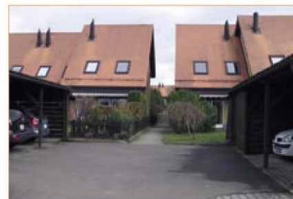
Le regroupement des garages permet de minimiser les nuisances liées à la circulation dans le reste du quartier.
