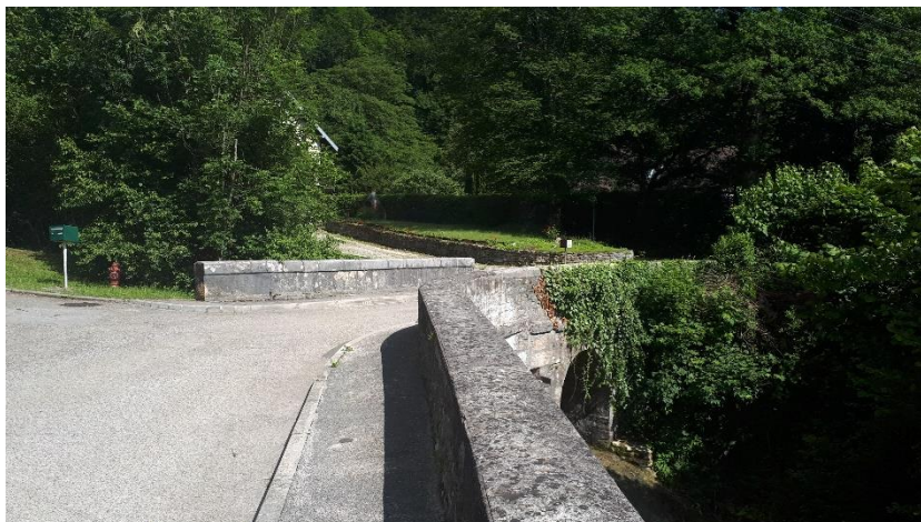
Pont surplombant le ruisseau de la Combe
