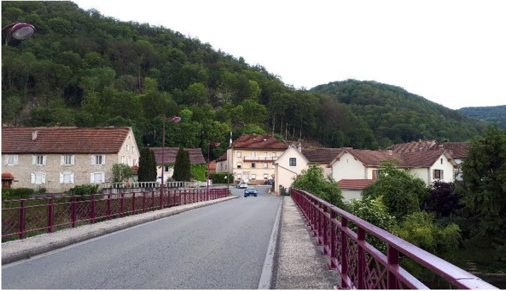
Pont de la Rue du Commerce – RD 36
