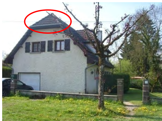
Construction intermédiaire avec une bonne qualité d'intégration paysagère et architectural avec toit en demi-croque récent
