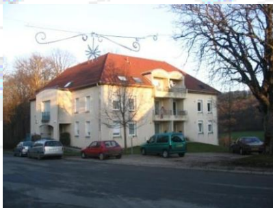
Logements collectifs à la sortie Nord-Est du village
