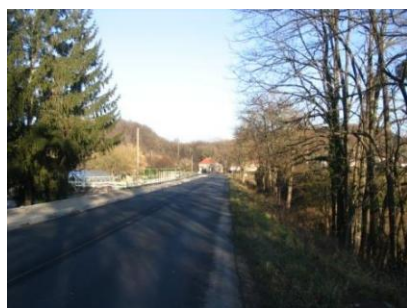
Entrée Sud (RD.105)
