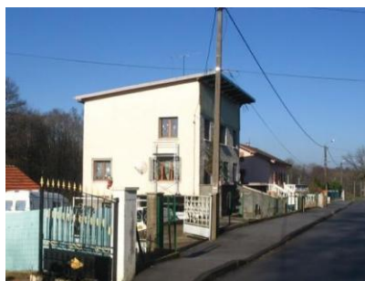
Construction à proximité de la voie ferrée
