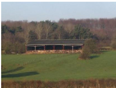
GAEC de la Tour : bâtiment situé au Vernois
