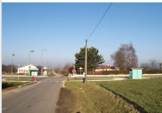
L'EXTENSION NORD ET SON ACCÈS
