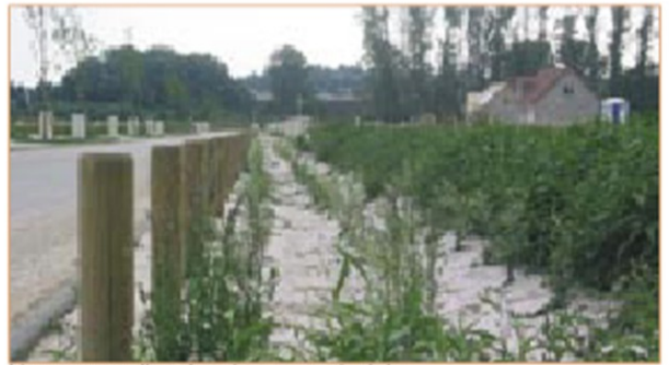
Une noue collectrice des eaux pluviales.
