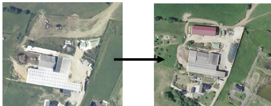
Photographies aériennes 2010 et 2022 du hangar d'activité. Source : Géoportail
