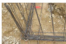
Noeud de chaînage - Continuité mécanique
