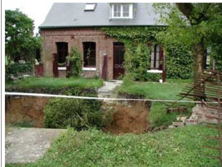
Conséquence d'un affaissement (Somme) – (Source : BRGM)
