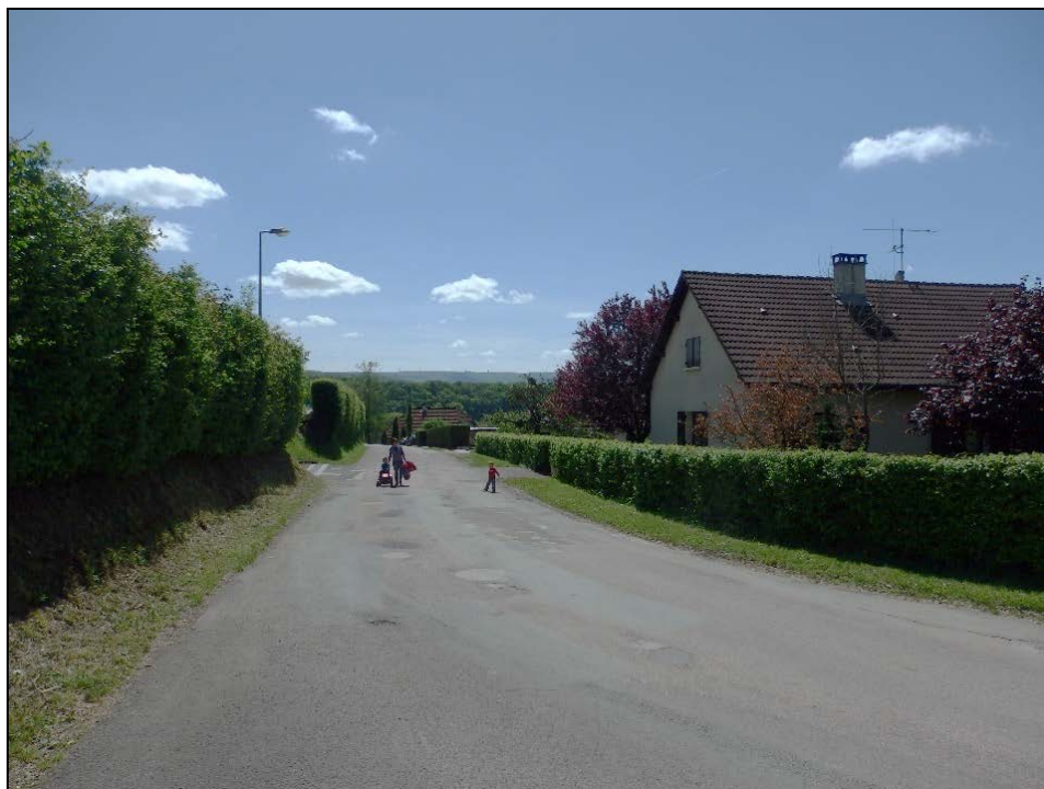
Exemple de voie partagée sans trottoir à Longeville-sur-Doubs
