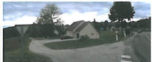
Vue proche : secteur bâti récent en retrait
