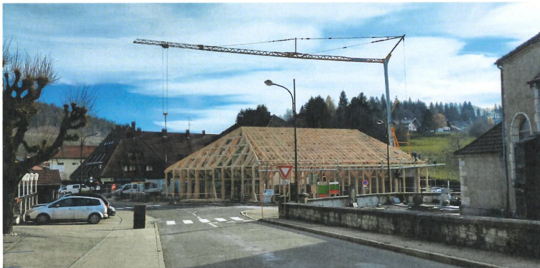
HALLE DE MARCHÉ EN COURS DE CONSTRUCTION
