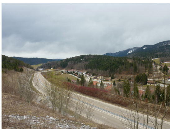
VUE SUR L'ENTRÉE SUD DEPUIS LA RN57
