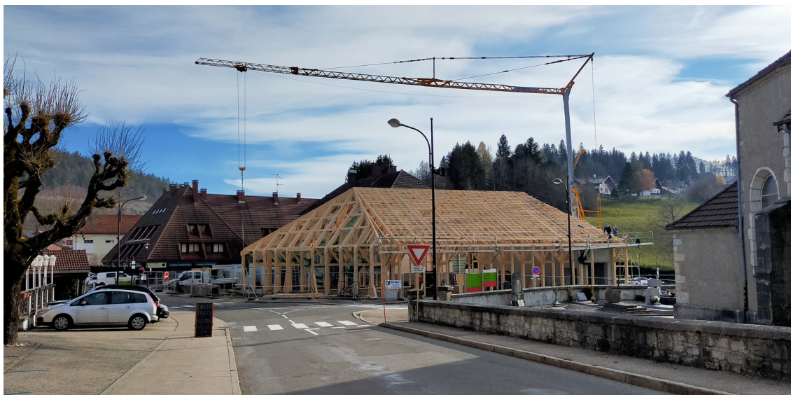
HALLE DE MARCHÉ EN COURS DE CONSTRUCTION
