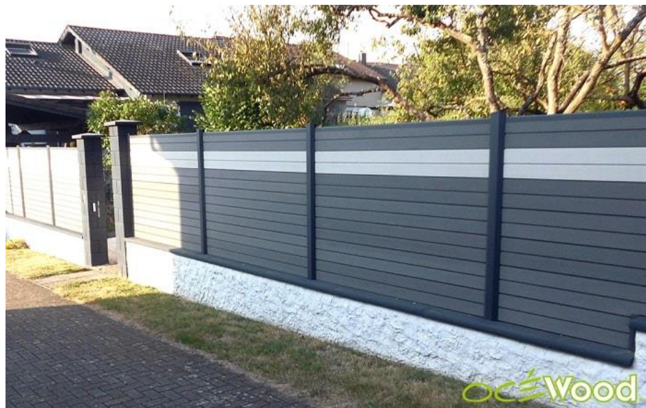
Illustration : clôture composite de 1,45m sur un mur bahut (Source : Océwood) : la hauteur totale dépasse nettement 1,5m
