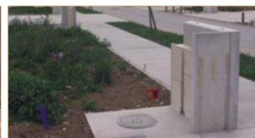
L'intégration des coffrets dans un petit muret construit à l'identique sur l'ensemble de l'opération permet d'en réduire les impacts.
