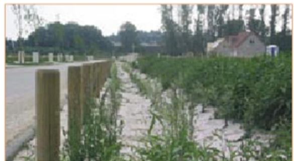
Une noue collectrice des eaux pluviales.
