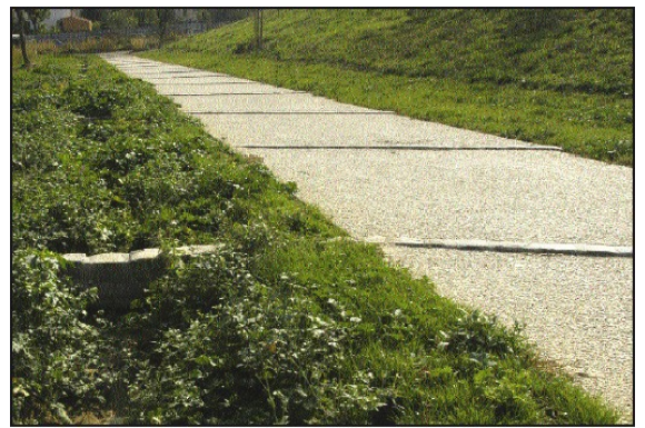
Allée piétonne et sa noue latérale
