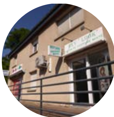
Enseignes perpendiculaires au mur
