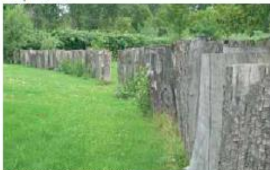
Des pieux de bois comme "clôture"
