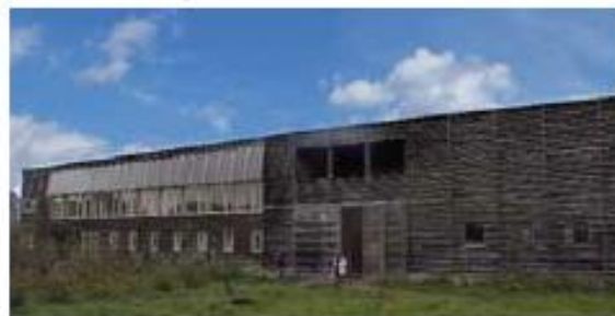
Utilisation des énergies renouvelables
