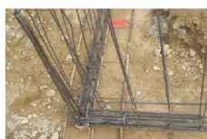
Noeud de chaînage - Continuité mécanique
