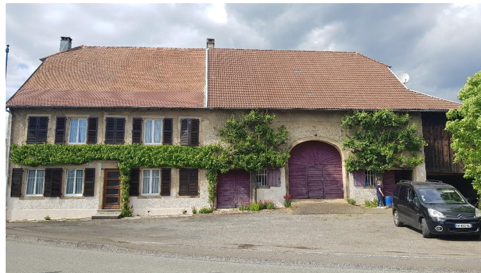
Ferme patrimoniale © Dominique Thiebault
