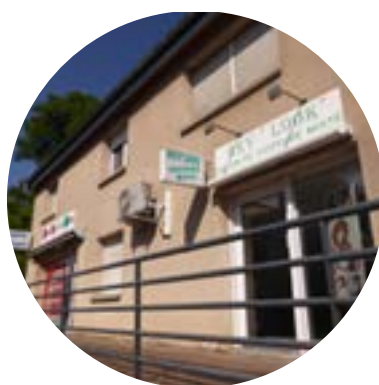
Enseignes perpendiculaires au mur
