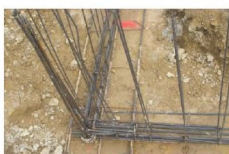
Nœud de chaînage - Continuité mécanique
