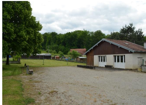
Bâtiment de stockage et terrain de sports en herbe
