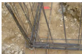
Noeud de chaînage - Continuité mécanique
