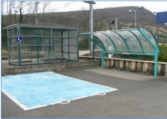
Stationnement vélos sur la halte ferroviaire
