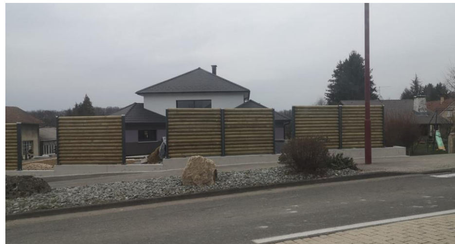
Illustration : exemple d'une clôture trop haute, rue de la Gare à Dasle, pour laquelle la Commune a dû demander au pétitionnaire de retirer plusieurs rangées de planches pour réduire la hauteur de la clôture.
