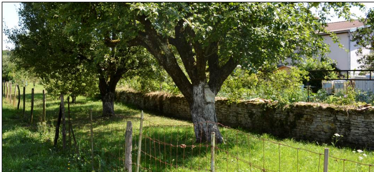
ECP 1 : mur en pierres sèches
