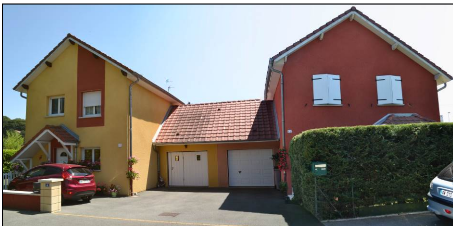
Maisons accolées par le garage
