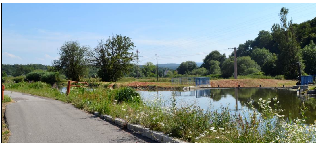
Vue sur la zone A depuis la rue du stade
