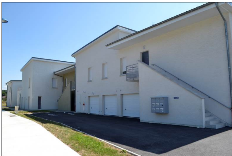
Deux bâtiments « Âges et Vies » proposant des logements (type studio) pour les personnes âgées, ainsi que des appartements à louer.
