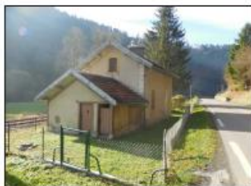
67- Ancienne gare - habitation actuellement
