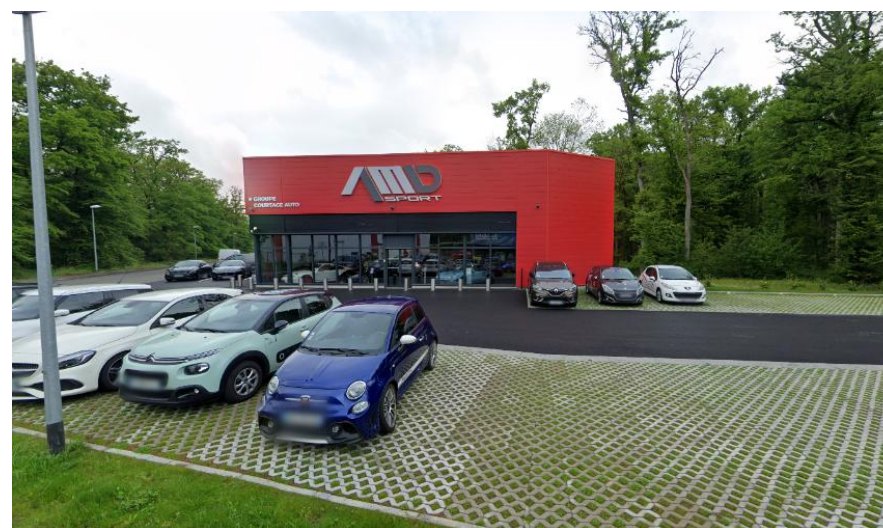
Parking désimperméabilisé - Zone d'activités de l'Allan (Vieux-Charmont)
