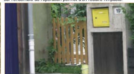
Boîtes aux lettres et coffrets de réseaux peuvent être intégrés aux murets ou à des éléments de clôture.
