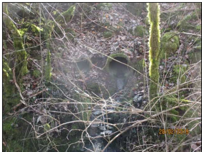
Localisation et photo de la canalisation de rejet des eaux prétraitées
