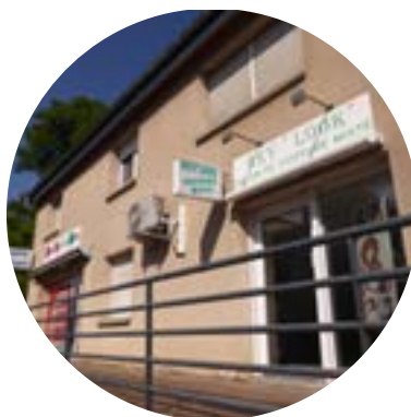
Enseignes perpendiculaires au mur
