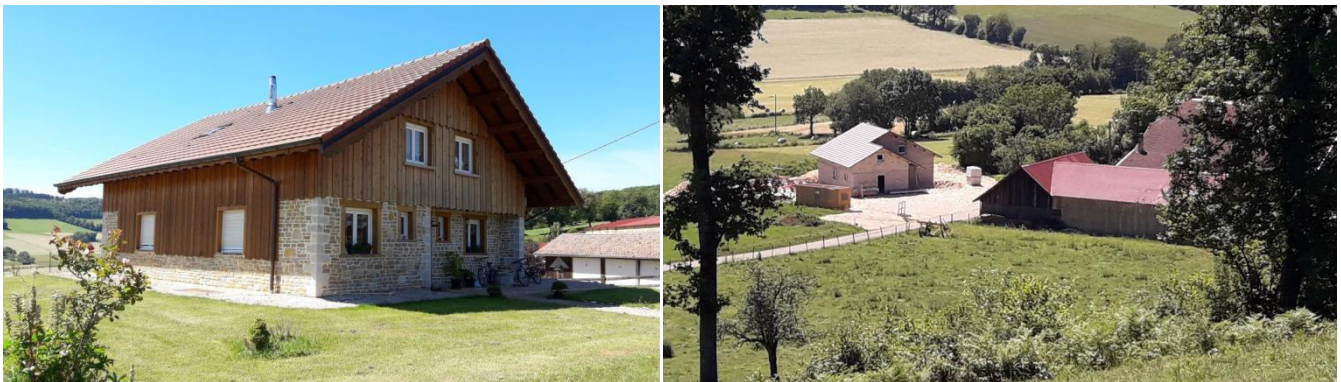
Maison d'exploitant du GAEC du Champ de l'Aigle et maison d'exploitant en cours de construction sur l'exploitation Laurent Damien
