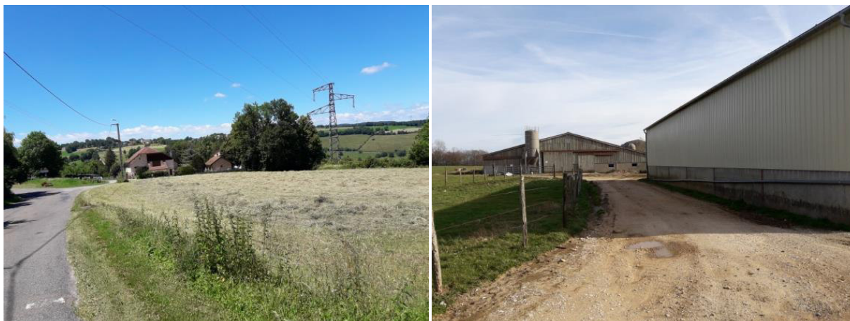
Ligne à très haute tension traversant le hameau de Châtillon - Importante exploitation agricole au Nord-Ouest.
