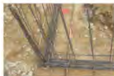
Nœud de chaînage - Continuité mécanique
