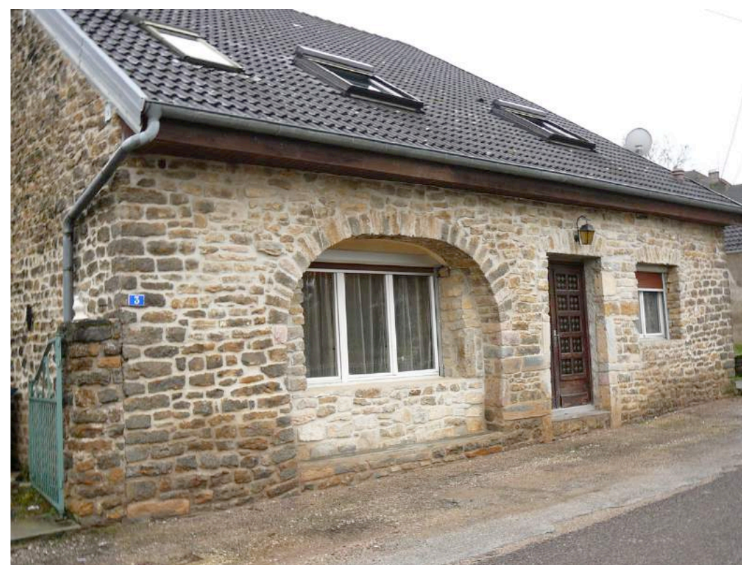
Maison en pierres, toiture en tuiles de forte pente et fenêtre en arche, Champvans les Moulins
