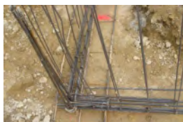
Nœud de chaînage - Continuité mécanique
