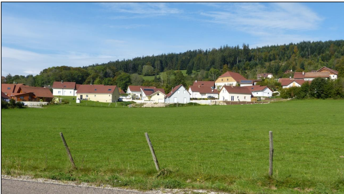
Vue des constructions récentes depuis la RD 237
