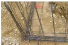
Noeud de chaînage - Continuité mécanique
