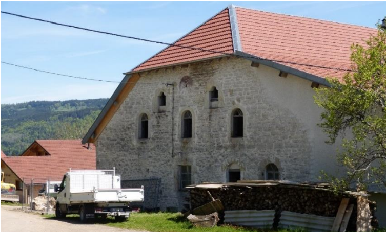
Photo : ferme comtoise en rénovation avec toiture à demi-croupe au Saucet
