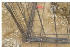
Nœud de chaînage - Continuité mécanique
