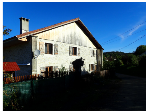
03 - ANCIENNE FERME (début XVIII ème ) Tous les éléments constructifs et significatifs d'une époque sont à conserver et/ou à conforter : toiture imposante à deux pans, avancée de toit importante, lambrequine*, levée de grange*, brise-bise*, ordonnancement des façades, encadrement des ouvertures en pierre de taille et en bois, ensemble de la porte d'entrée avec imposte*, linteau avec corniche* et 'médaillon', menuiseries bois.
