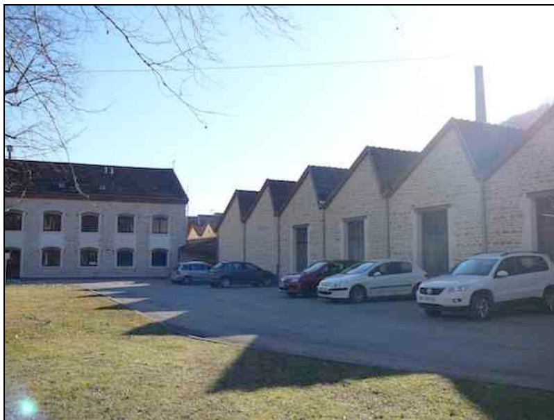
Entrée du site de la papèterie
