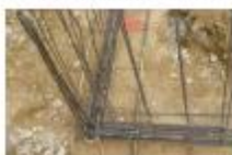
Nœud de chaînage - Continué mécanique
