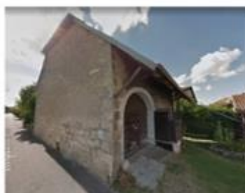
Avancée de toiture sur console - 3 rue de l'Esplanade
