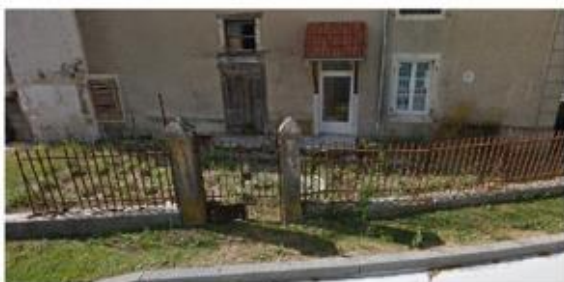
Clôture fer forgé + portail sur façade arrière - 2 rue des Tilleuls
