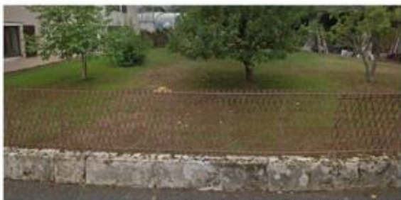
Clôture métallique sur mur bahut - 13 Grande rue
