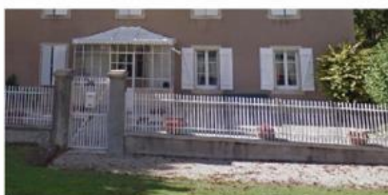
Clôture métallique sur mur bahut + portail 3 rue Neuve
