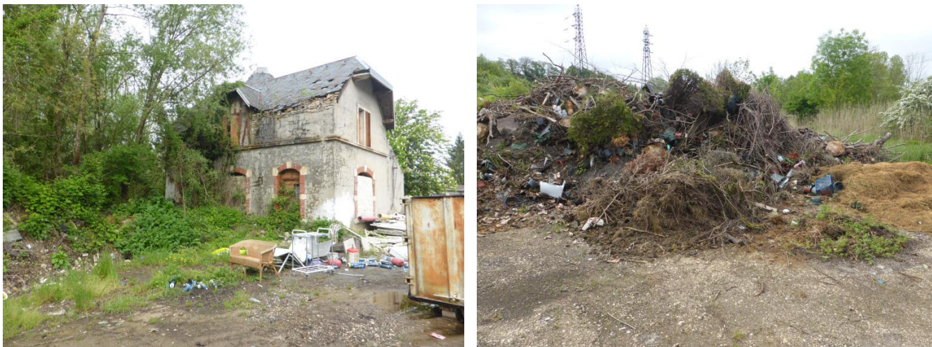
Dépôts de terres, matériaux souillés et déchets divers dans la friche de l'Herbie
