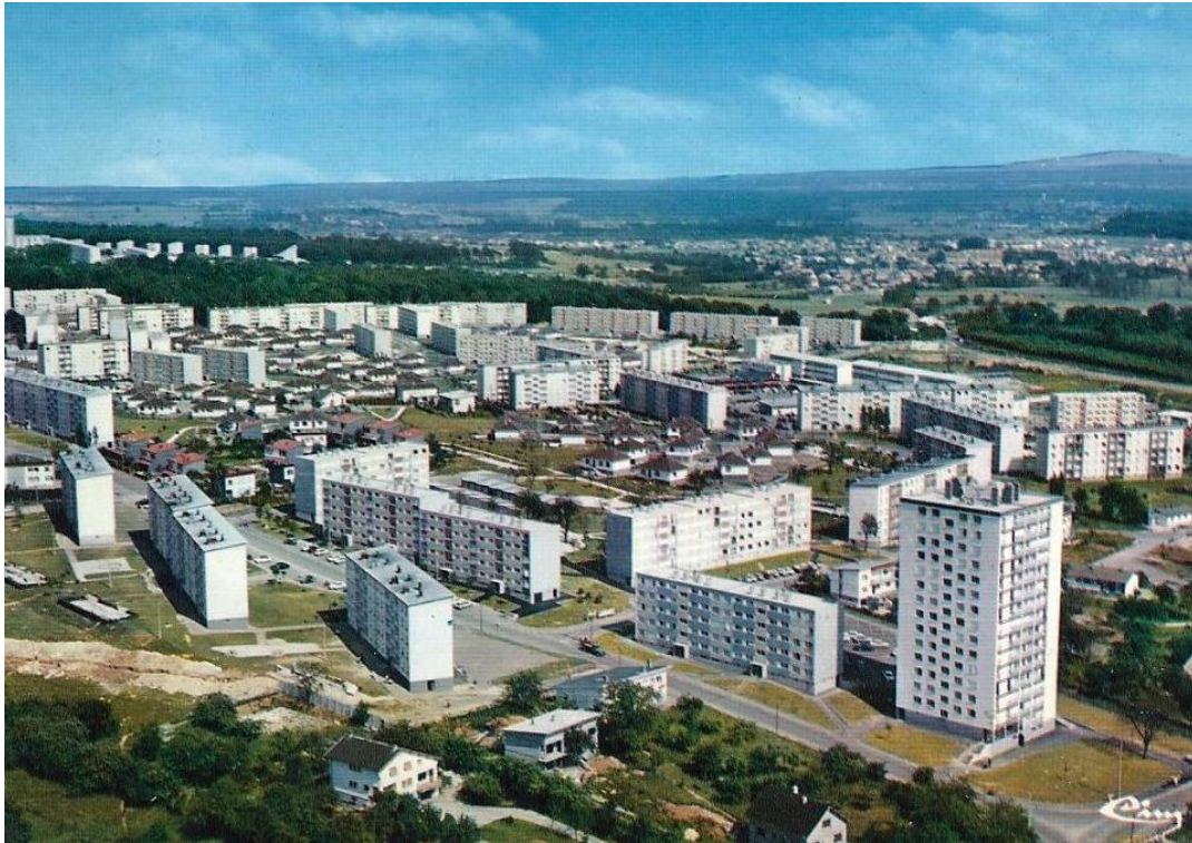
La tour 40, démolie en 1998
