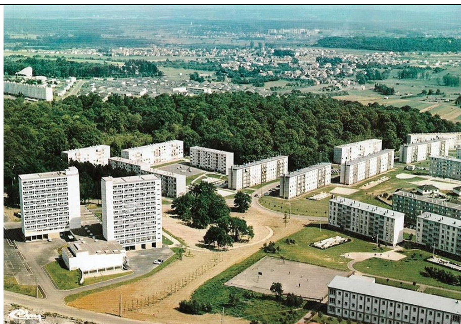
Un poumon vert accessible aux habitants de Bethoncourt et de Grand-Charmont
